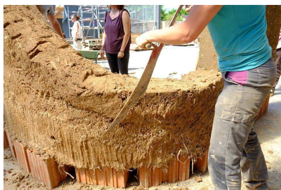
(c) Séchage et rectification du mur
