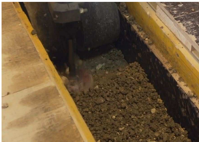
(a) Compaction d'un mur en pisé
