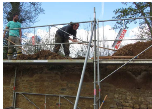
(b) Empilement de la bauge
