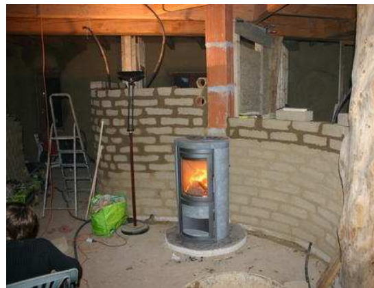
(b) Mur d'une maison en adobe
