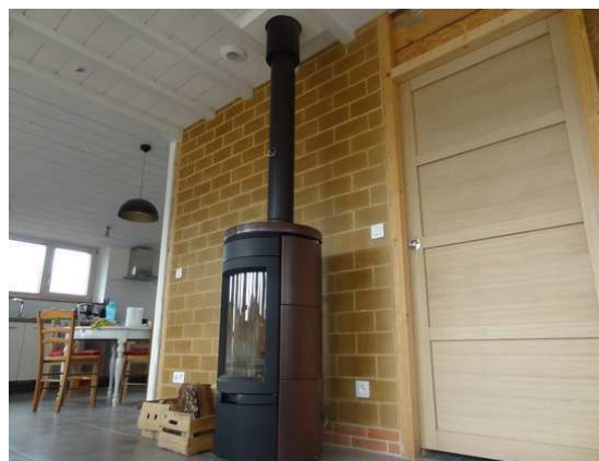
(b) Cloison en brique de terre compressée
