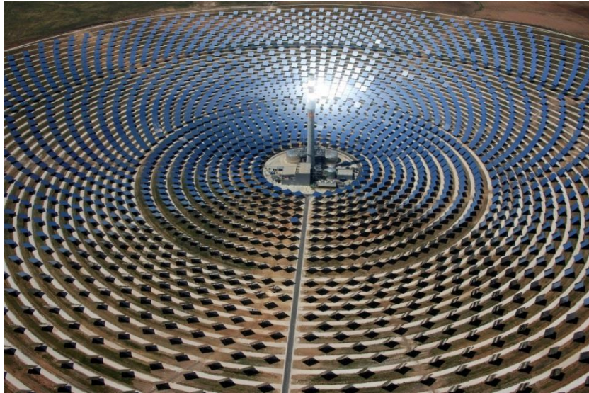
Figure 1.37 - Tour solaire à concentration "solar Tres".
