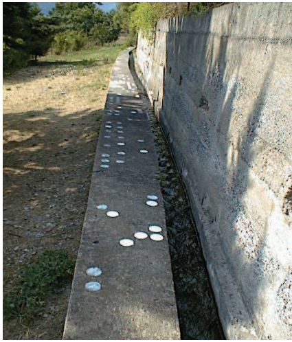
Vue sur le canal depuis la maison dans le contresens de l'écoulement
