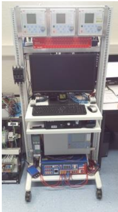
Figure 22 ; Ancien banc de test
