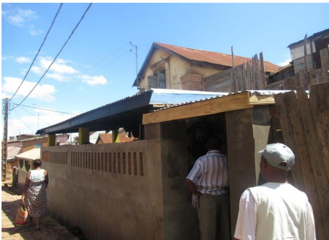
Photo n°8: Le lavoir en cours de finition.
