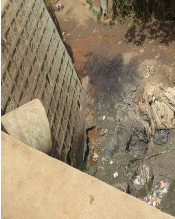
Photo 21 : La chute de Lilly, le second canal d'évacuation des eaux usées
