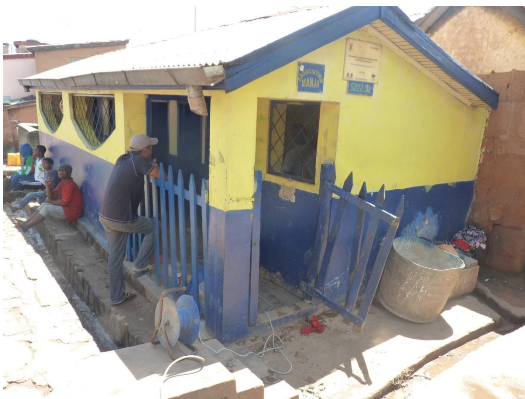
Photo n°6 : Le bloc sanitaire à Manjakaray II-C.
