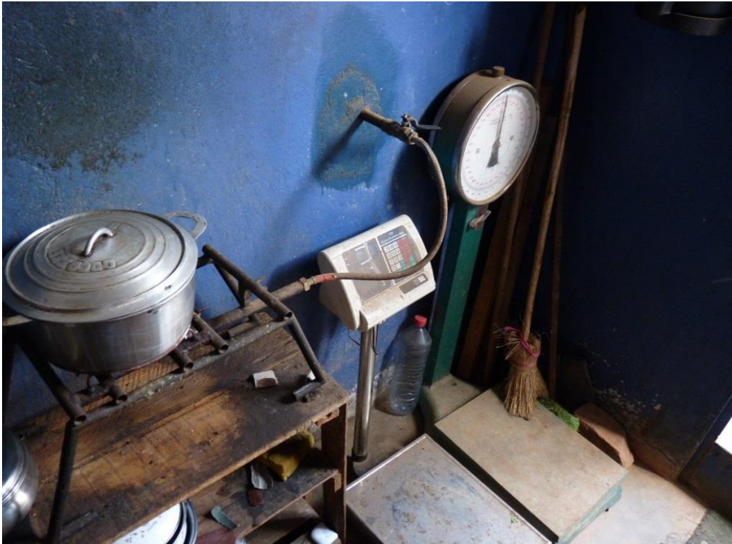
Photo n°23: Une cuisinière alimentée en méthane produite par la station de traitement des boues de vidange.
