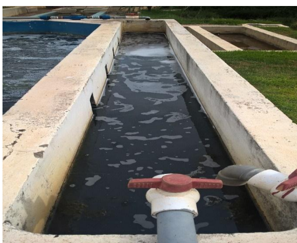
Figure 8 : Entrée de l'eau dans le bassin
