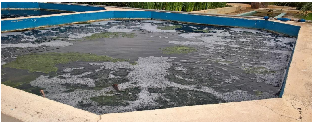
Figure 6 : Le premier bassin à pouzzolane
