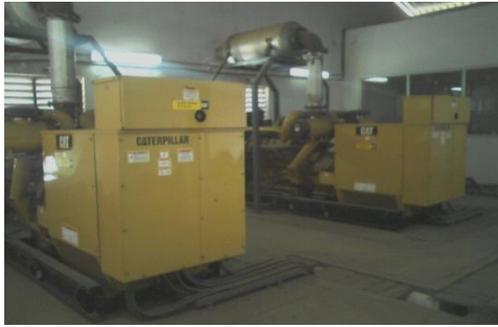
Figure 12 - Les 02 groupes électrogènes de 544kW installés pour l'Usine
