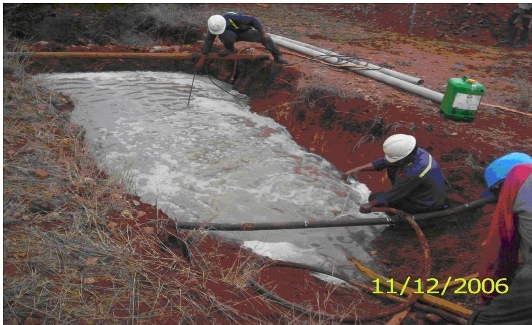
Photo N° 3. Préparation de la boue de forage
