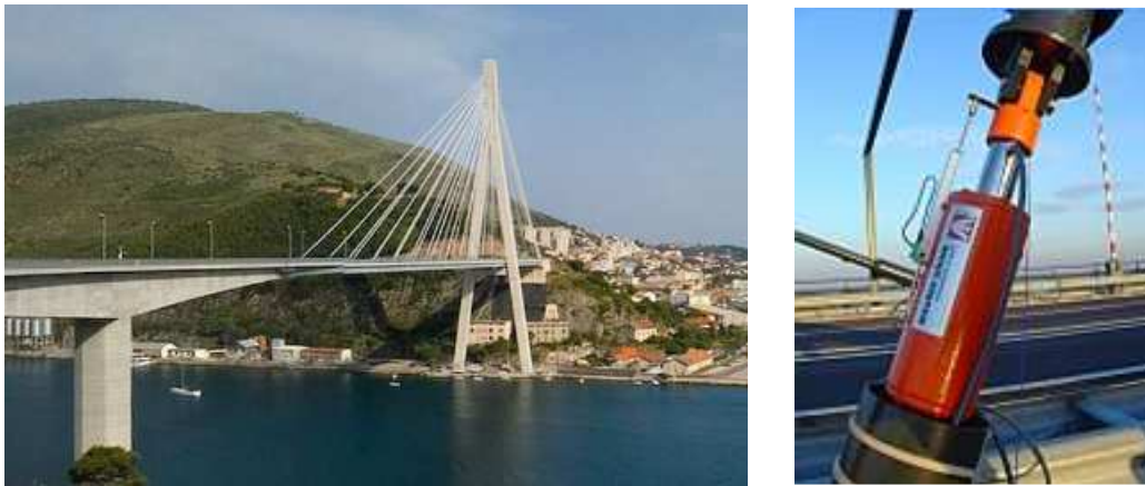
Figure A.6 - Installation d'un amortisseur MR sur un pont à haubans en Croatie
