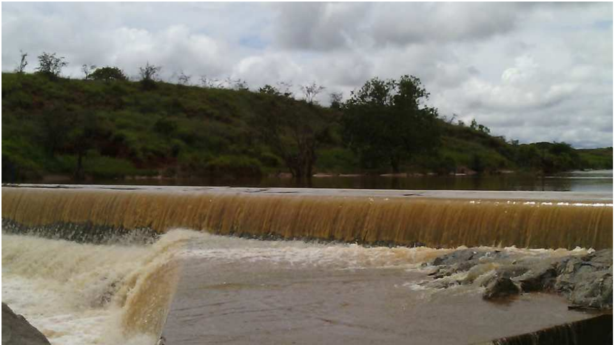
Figure 2 : Photo de captage du barrage
