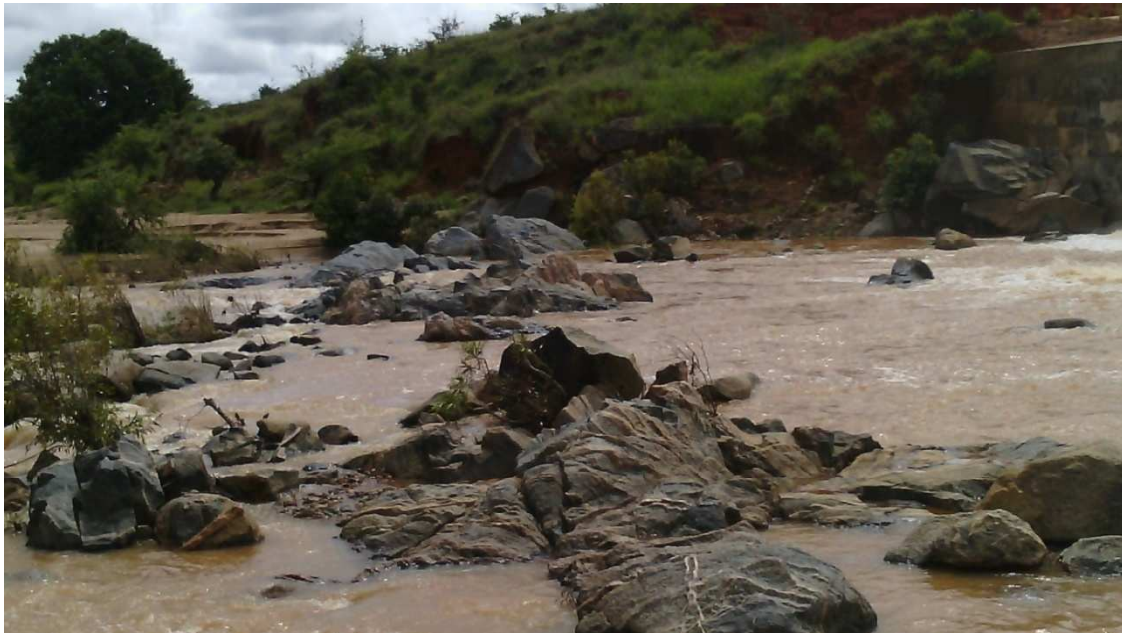
Figure 3 : état de l'eau du barrage
