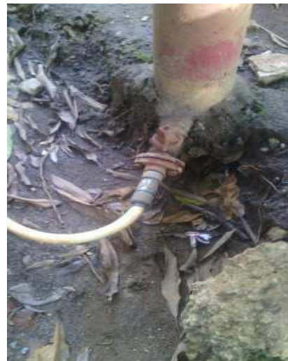
Figure 7 : Injection de la chaux
