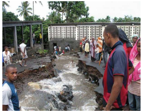
Photo 5. Dévastation de la route, (Source, COSEP)
