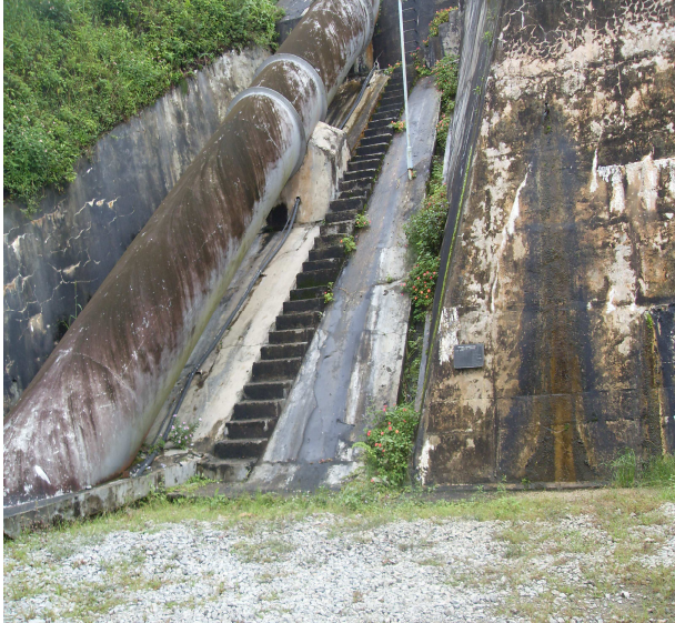
Photo N° 2: Dénivellation de la Centrale hydroélectrique de Ranomafana.
