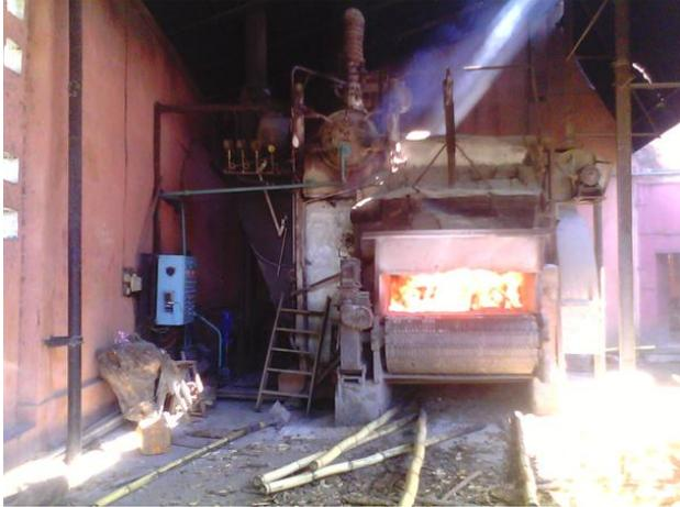
Figure 11 : Chaudière à tube d'eau
