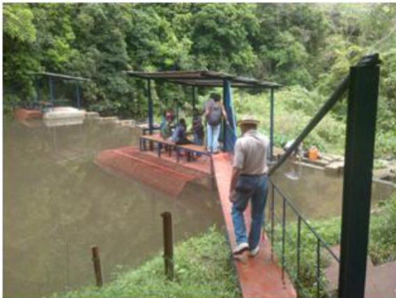
Photo I : Vue amont des deux prises d'eau de la JIRAMA
