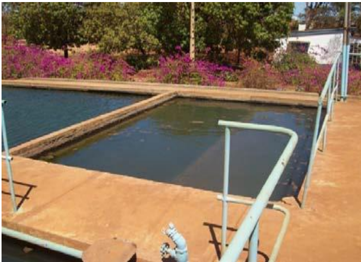
Photo 4 : Bassins de décantation
