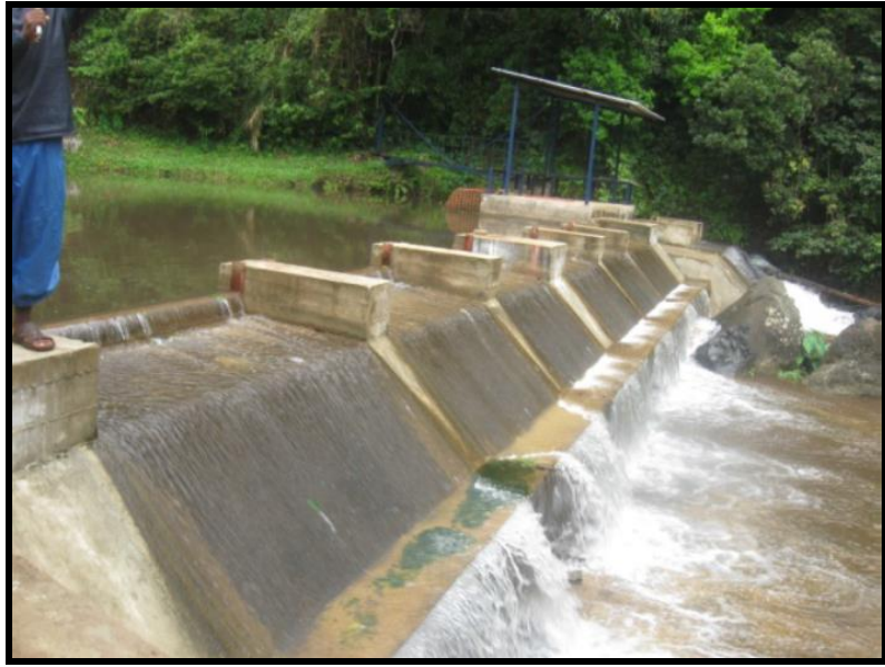
Photo 2 : Barrage JIRAMA : rehaussement du seuil du barrage
