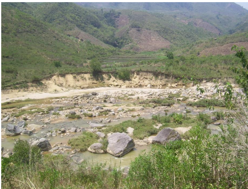
Photo 11: forte érosion de la berge
