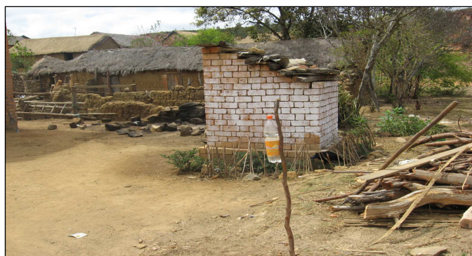
Photo n°4 : Latrine avec un tippy tap à côté
