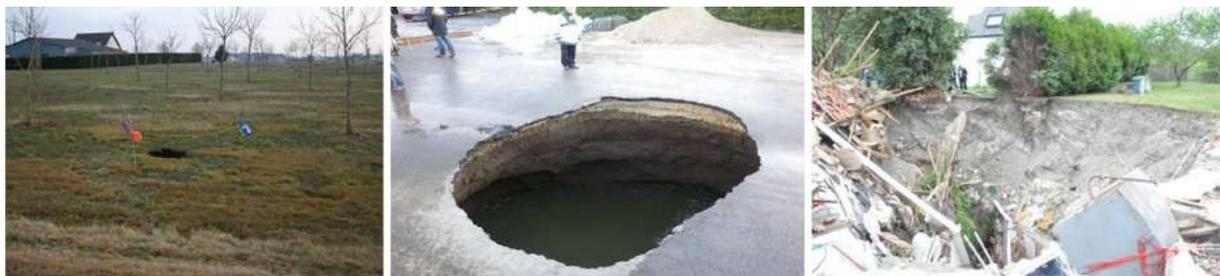
Figure l: Exemple de fontis de différents diamètres
