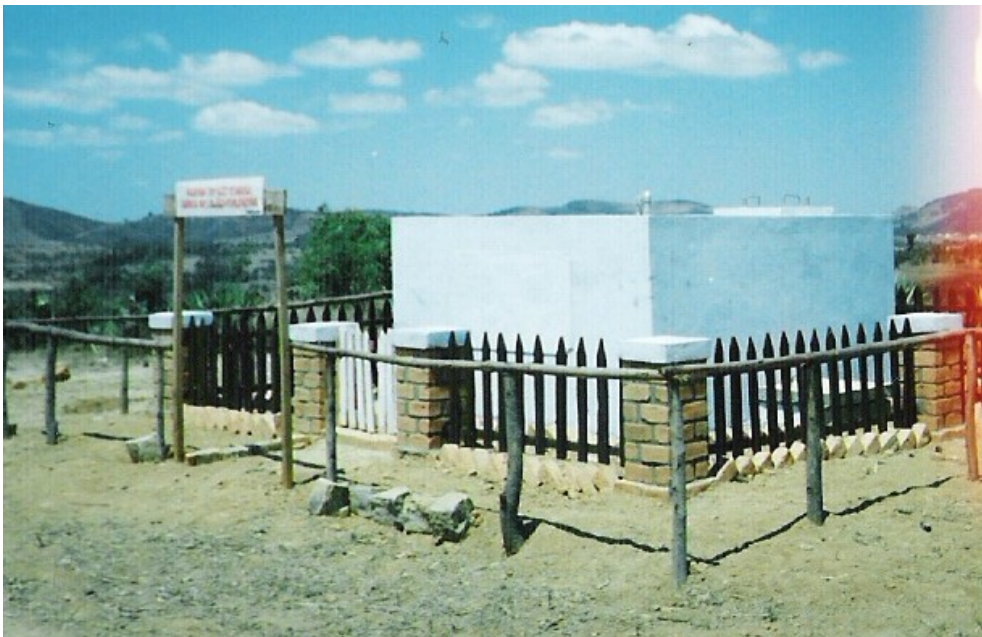
Photo n°2 : photo du réservoir réalisé par CARITAS à Merikanjaka
