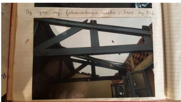
Photo 7 : L'ensemble de la toiture détruite suite au passage de Chezda dans le CEG d'Ambohimanarina<sup>54</sup>
