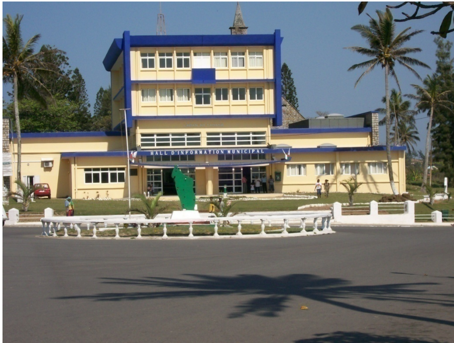
Cliché : Auteur, Septembre 2008
