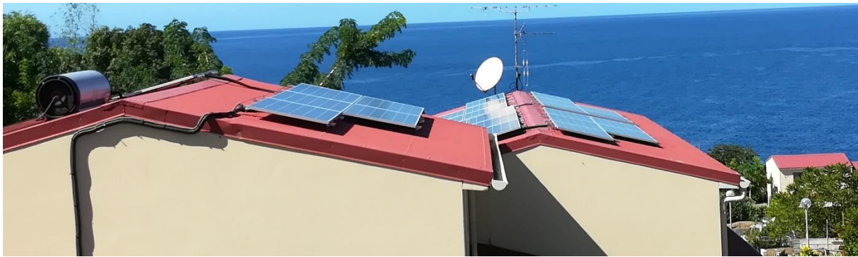
Photo 15 : Chauffe-eau solaire et panneaux photovoltaïques sur les toitures d'habitations, sur la commune du Prêcheur.
