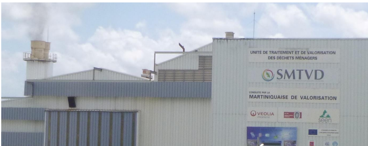
Photo 13 : L'usine d'incinération des ordures ménagères à Fort-de-France.
