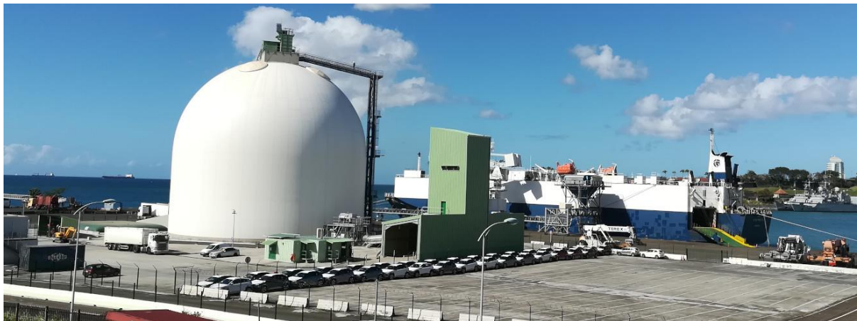
Photo 10 : Structure d'approvisionnement en combustible bois sur le port de Fort-de-France, à Pointe des Carrières.
