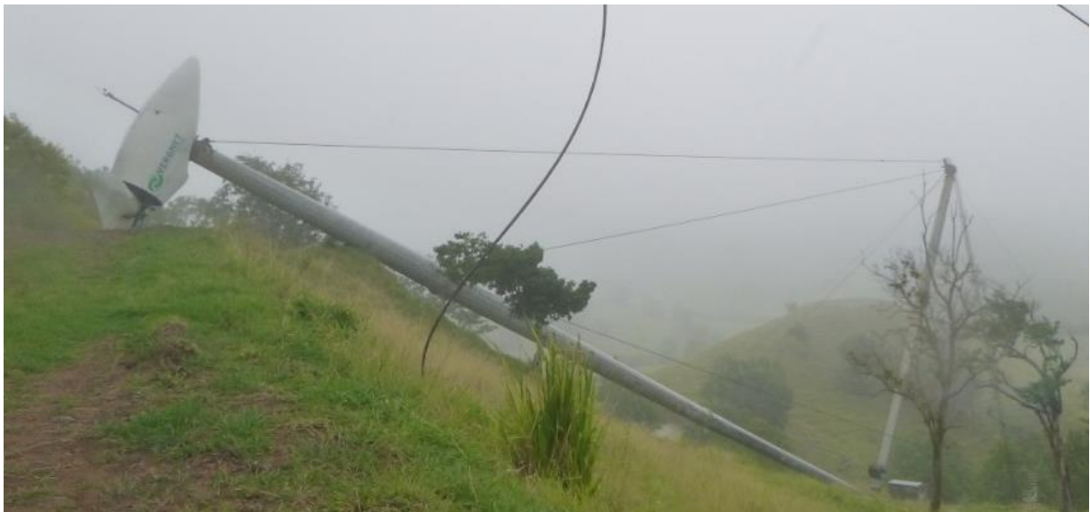
Photo 25 : Les éoliennes du Vauclin couchées pour maintenance.
