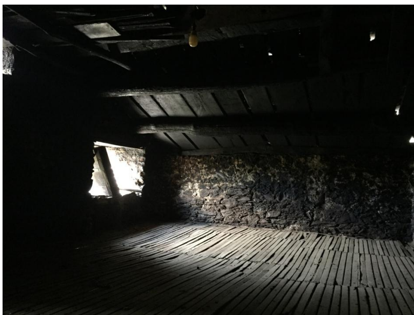
Figure 17 : étage supérieur d'un séchoir. Sur le mur de gauche, trois fenêtres permettent de contrôler les courants d'air. Sur le mur de droite, une porte permet de déposer les châtaignes sur les claies. (Nocario, 15/06/2020)© Doria Bellache.
