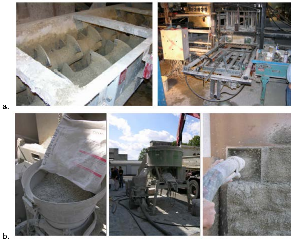
Figure 1.12. Fabrication et mise en œuvre de béton de chanvre : (a.) préfabrication de blocs à l'aide d'un malaxeur et d'une presse à blocs, (b.) mélange sec réalisé au malaxeur puis appliqué par projection (ajout d'eau dans la lance) [Collet et al. 2013].
