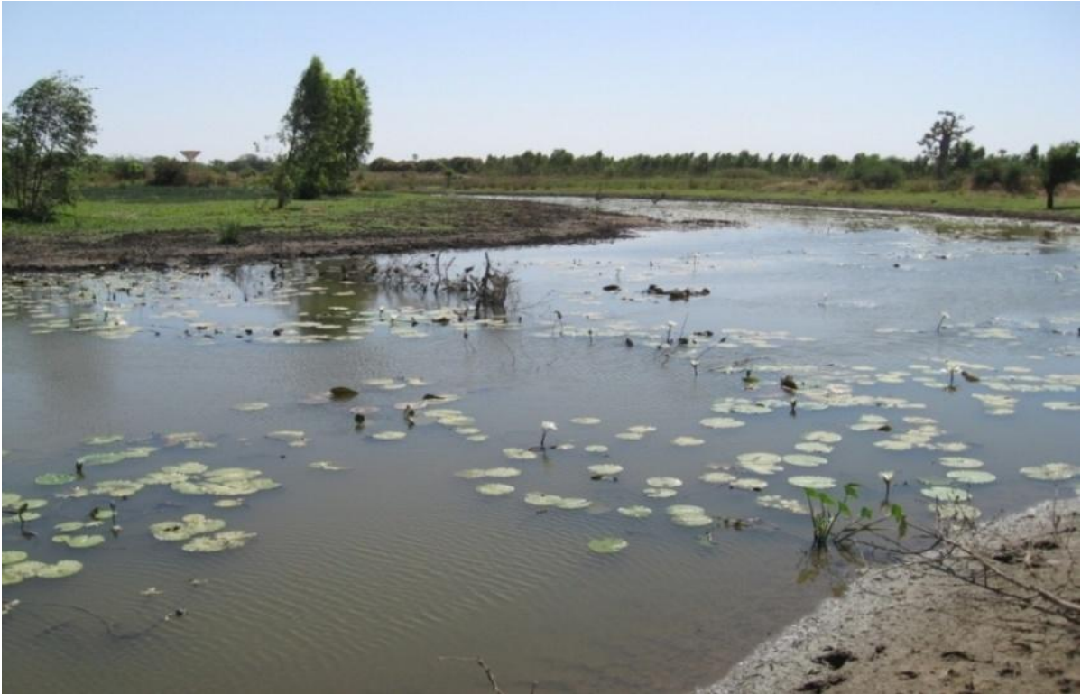
Photo 1 Bassin de rétention du village de Nguéniène (2013)
