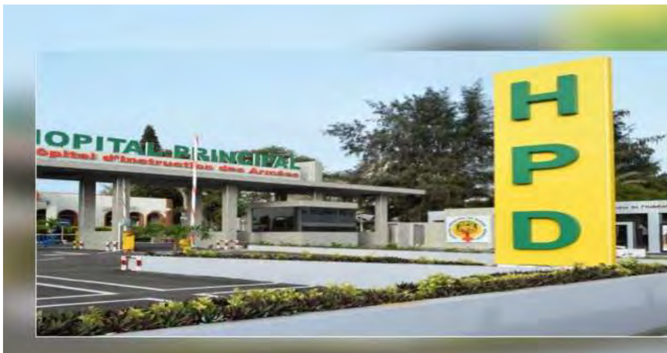
Figure 17 : Porte d'entrée Hôpital Principal de Dakar (cellule information HPD)
