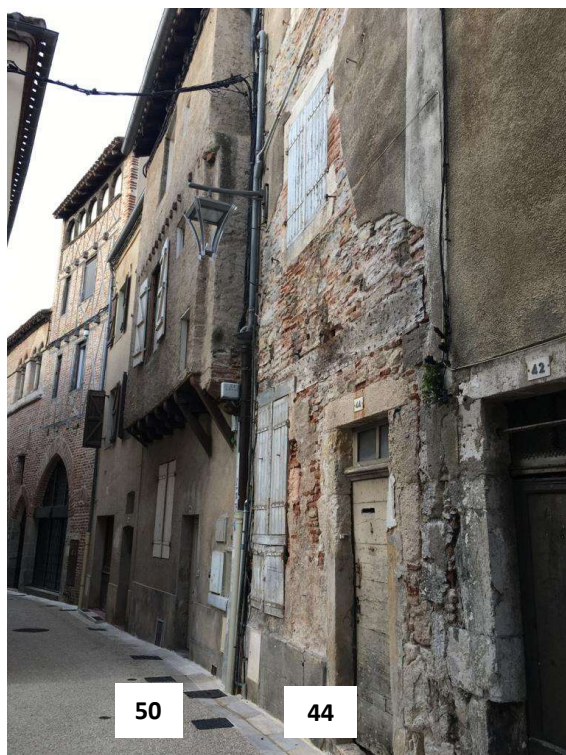
Figure 66 - Façade est des bâtiments depuis la rue Saint-Urcisse numéro 50 à gauche et numéro 44 à droite.
