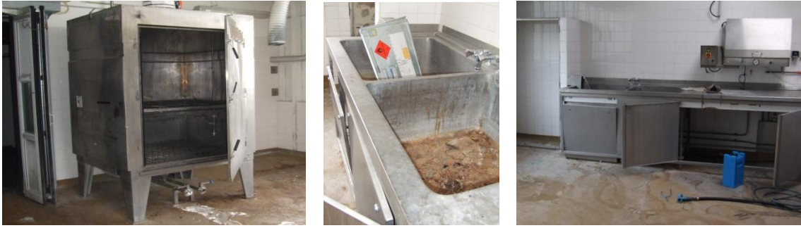
19. Infrastructures d'une laverie désaffectée (Aromatics) (Cl. P. Rosini)
