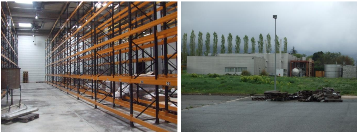
7. Usine désaffectée ( Aromatics , Grasse 06) (Cl. P. Rosini)
