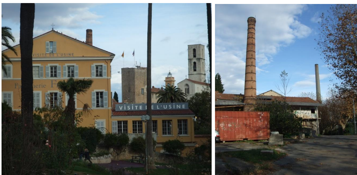
2. Grasse : Cheminée ; « Usine-musée » et « usine-vestige » (Grasse, 06) (Cl. P. Rosini)
