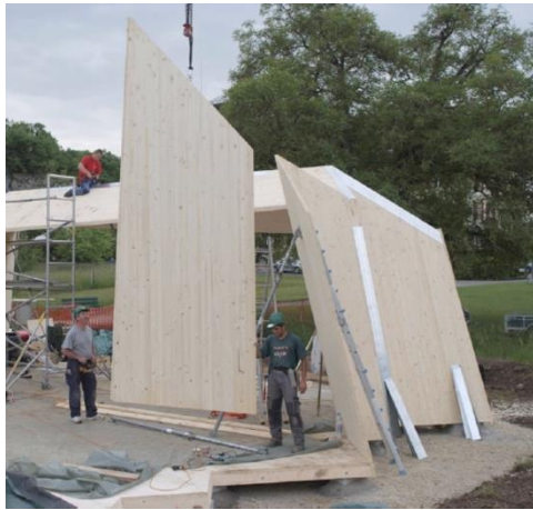
Figure 14 A. Assemblage de la Chapelle Saint-Loup (Buri, 2010); B. Hiérarchie/coordination de montage pour les assemblages internes (Stotz, 2009)
