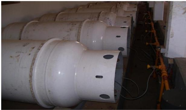
**Figure 13 : Bouteilles de Chlore « désinfectant ».**
