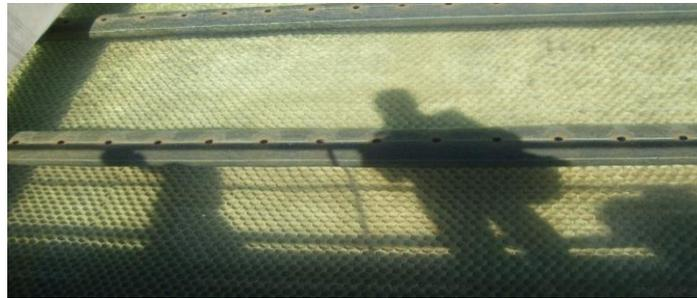
**Figure 10 : Décanteur lamellaire en plastiques.**
