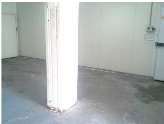
Figure 37: L'état de la zone après le nettoyage
