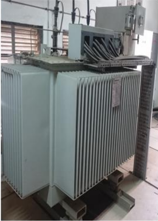
Figure 11 : Caractéristiques du Transformateur 1000 KVA
