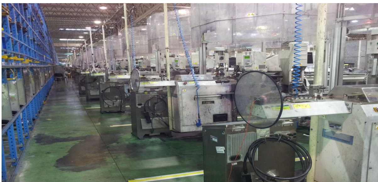
Fig5 : les machines de coupes alimentées en câble des bobines (la zone coupe)
