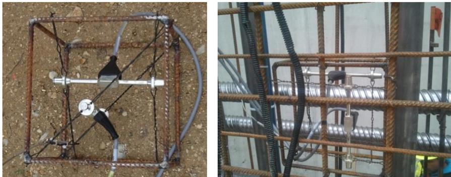
Figure 19. Capteurs de déformation à corde vibrante conditionné dans leur « cage » (à gauche) pour être placé dans le ferrailage (à droite) (© EDF).
