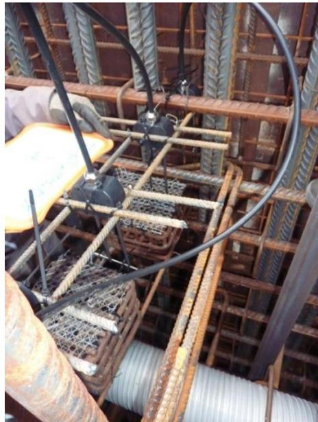
Figure 46. Capteurs TDR mis en place dans la levée 11 de l'enceinte de Flamanville 3.
