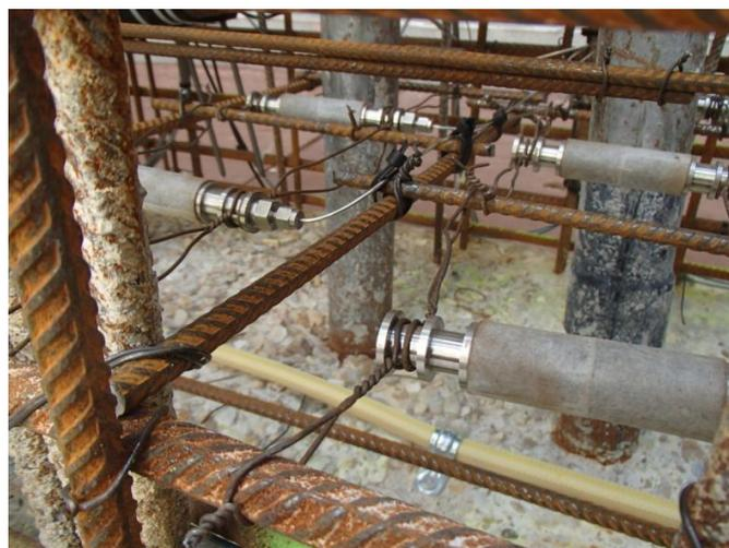
Figure 41. Capteurs de technologie « pulse decay » mis en place avant le bétonnage © EDF.
