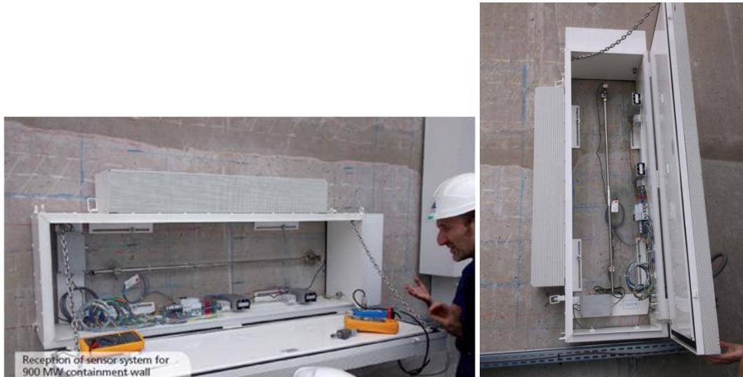
Figure 21. Capteurs de parement installés sur site (© EDF).
