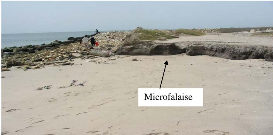
Photo 6 : Micro falaise due à l'érosion à l'extrémité du mur du cimetière de Thiawlène montrant le recul du rivage (prise le 19 octobre 2005)
