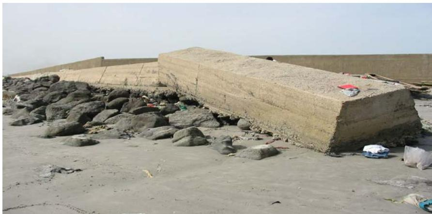
Photo 2 : Rupture et effondrement de l'extrémité Sud du mur de protection du cimetière musulman de Diokoul en juillet 2005 (prise le 19 octobre 2005)
