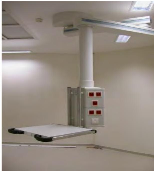
**Figure 11:** Bras chirurgical à hauteur fixe
