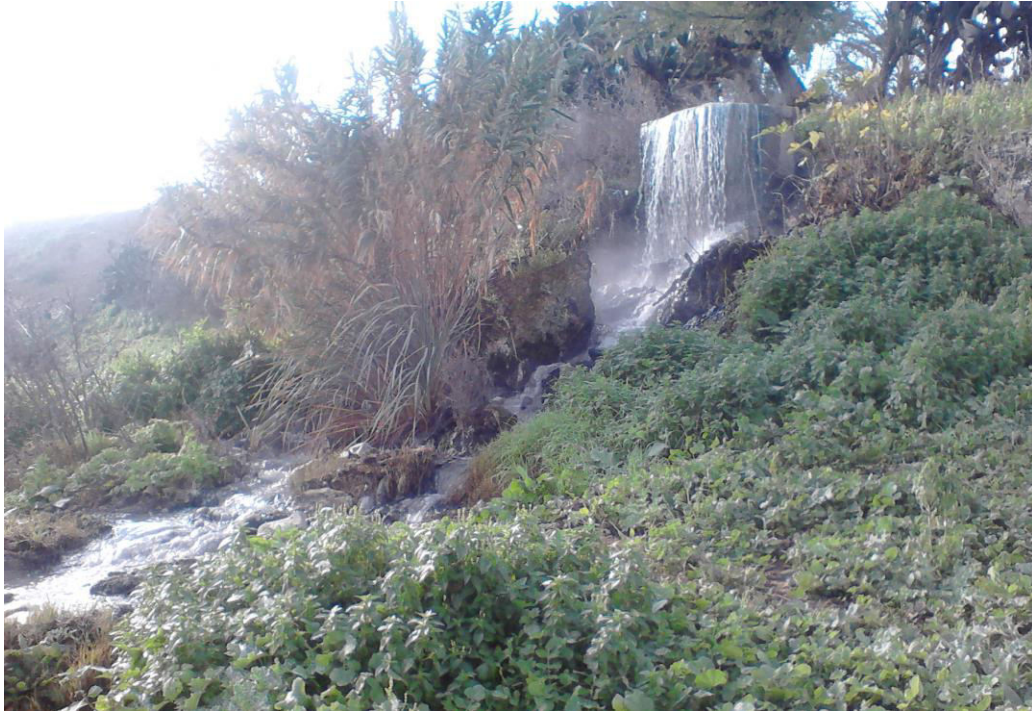
Figure 29. Débordement de réseau d'assainissement à la suite de forte pluie (Hammam Debagh à 10 m de l'oued Bouhamdane), (Khadri, 2017).
