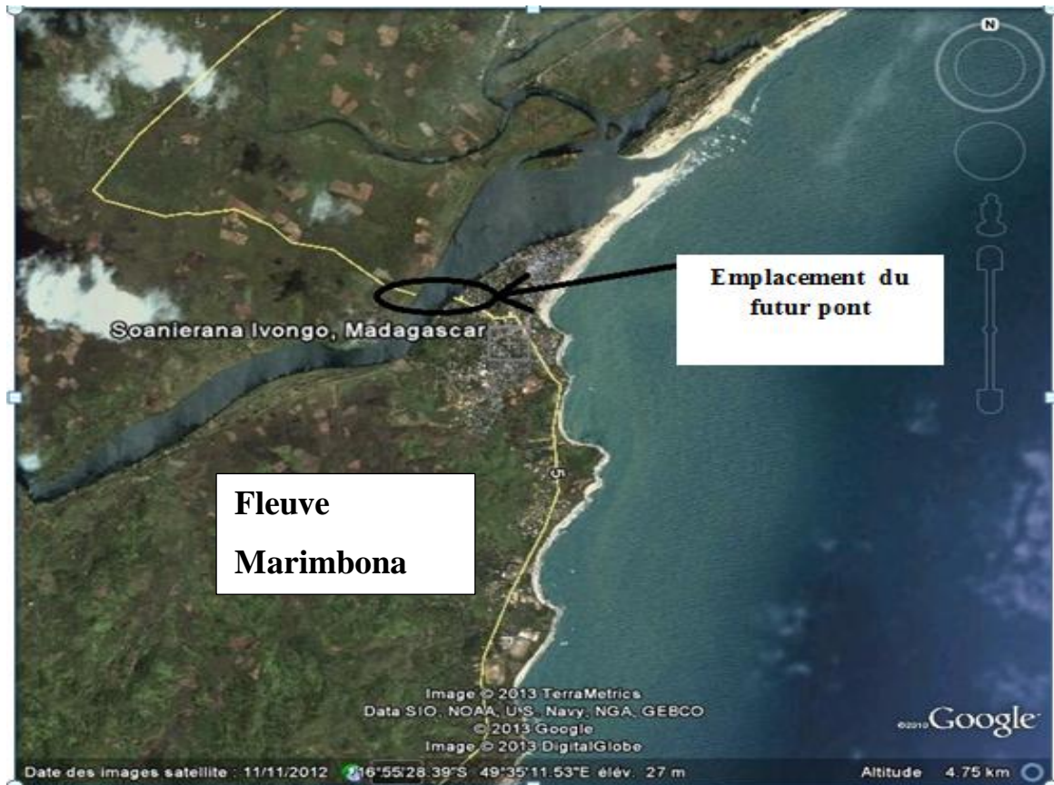
Figure 1: Observation satellite de l'emplacement du futur pont
