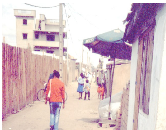
Photo 10 : Dégradation au PK 0 + 350 (Rue Anosibe – Anosipatrana)
