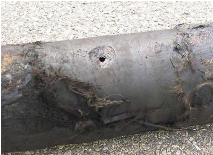
Figure III. 8 Corrosion externe (perçement d'un pipe, zone chaude) [37].
