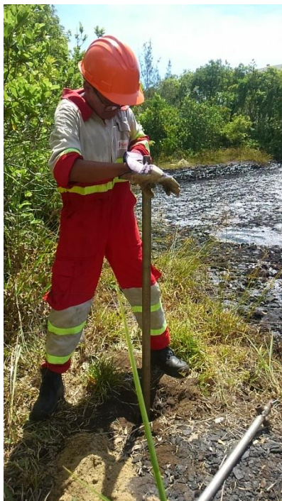
Photo 3 : Carottage de sol
