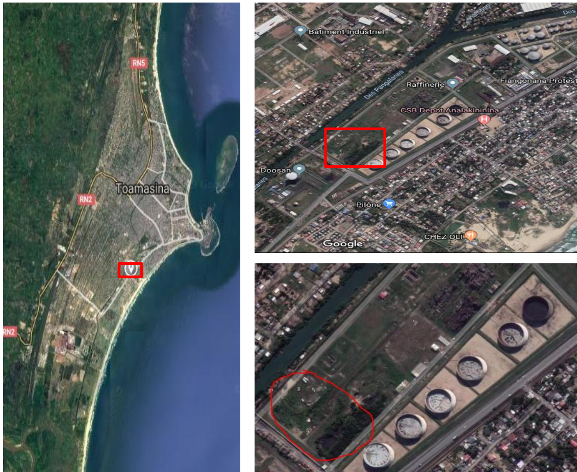
Photo 2 : Vue aérienne du site étudié (Google Maps le 14/03/2019)
