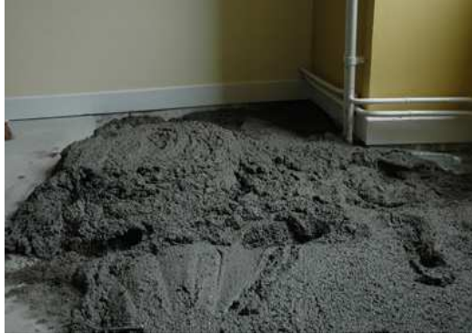
Photo 3 : Chape légère en béton léger de PSE
