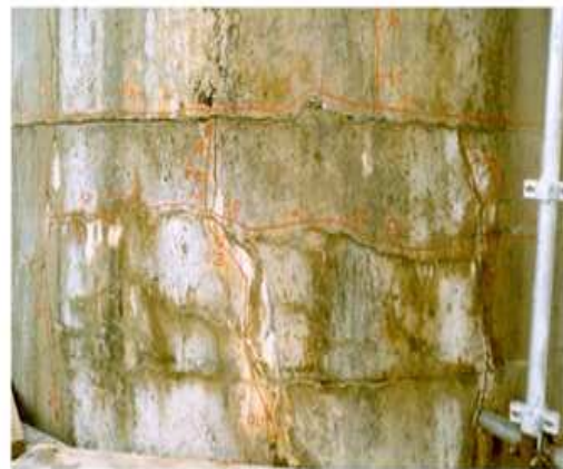
Figure 2-2 Désordres sur la culée du pont d'Onde
