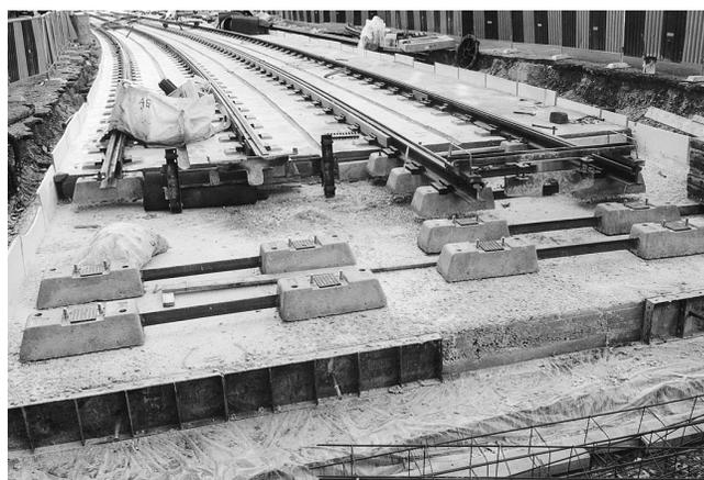
Figure 4 – Construction d'une voie de tramway (Strasbourg)
