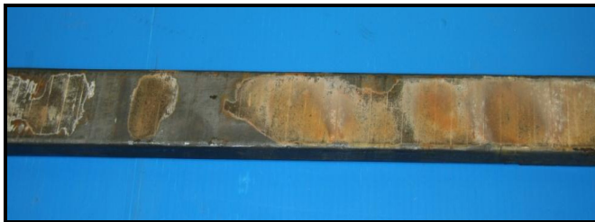
Figure 1.3 Une barre ayant été soumise à des DP d'encoche de nature purement électrique
