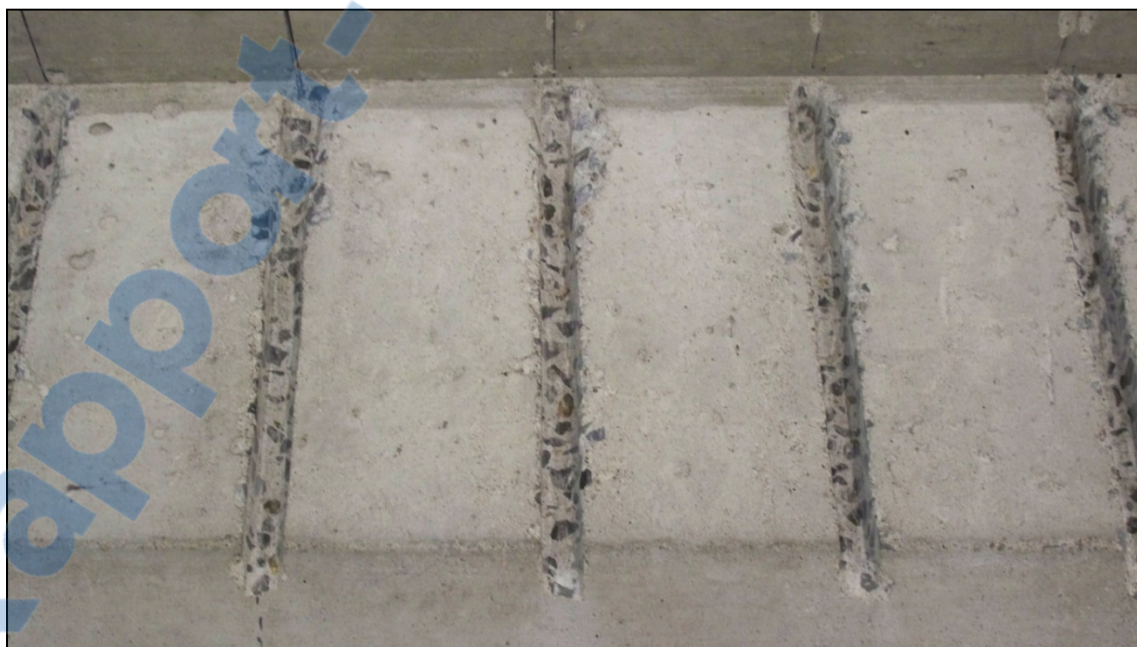
Figure-A II-3 Nettoyage des rainures.
