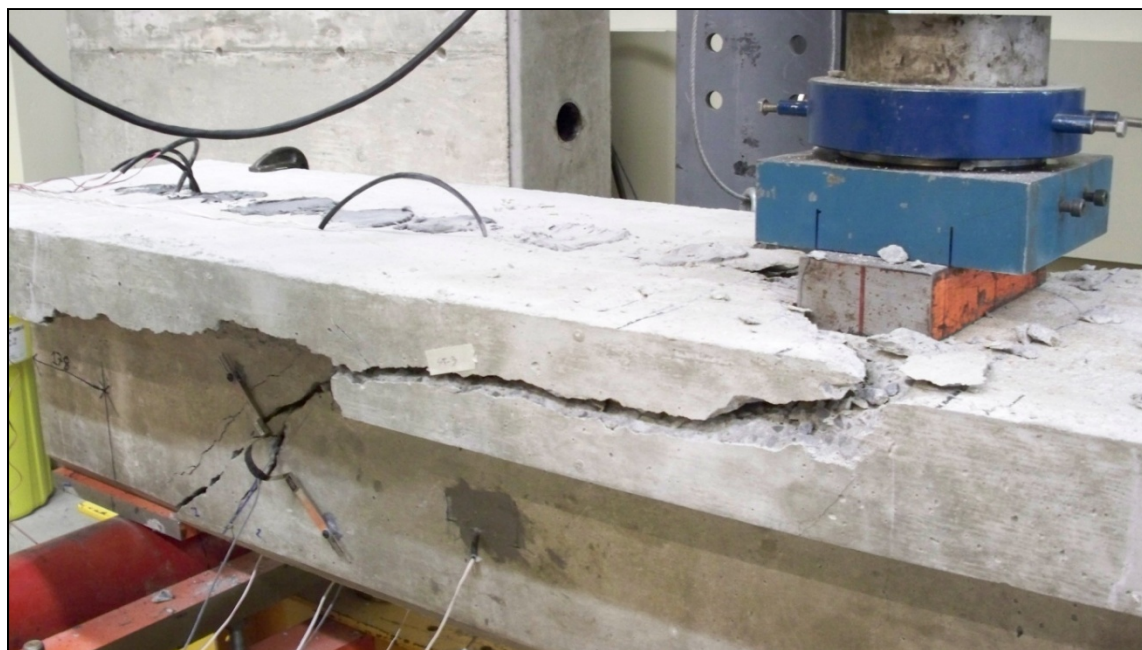
Figure 11.2 Effritement du béton sur le spécimen F0-FE.
