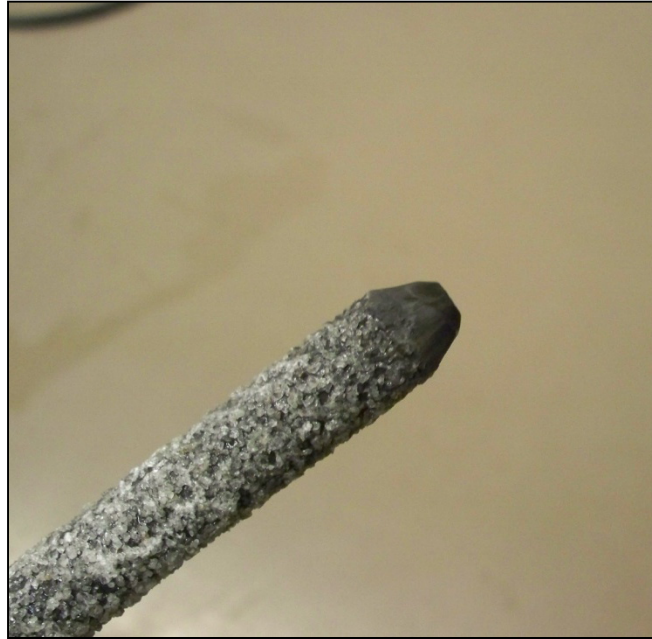
Figure-A II-8 Aspect de l'extrémité des barres implantées.
