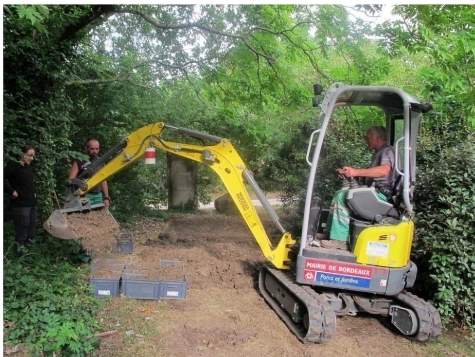
**Figure n°25** : Photographie de la mini-pelle remplissant les caisses de sol pollué
