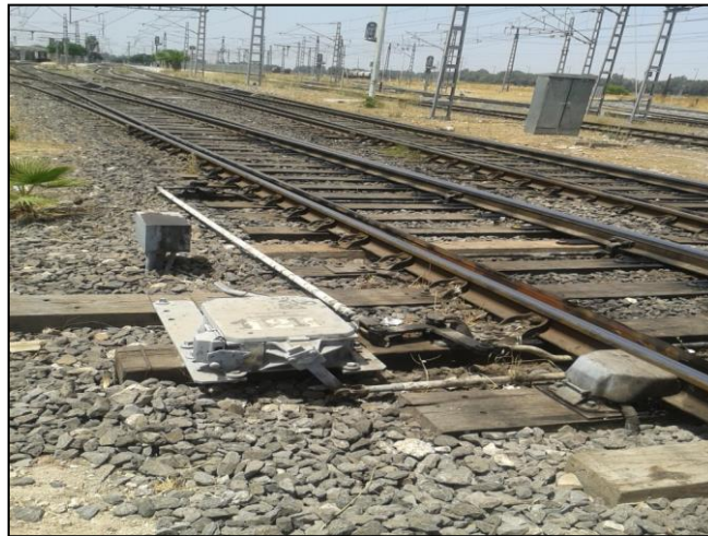
Figure 10 : Aiguille à commande électrique
