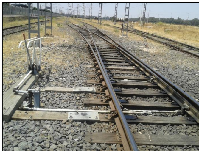
Figure 11: Aiguille à commande manuelle
