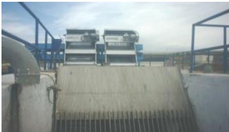
**Figure n°2:** le dégrilleur (original).
