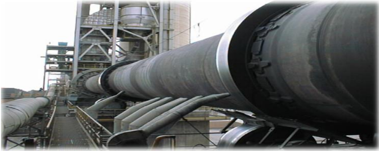
Figure 11 : La tour de préchauffage et le four
