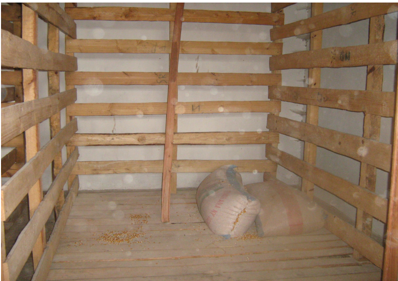
Photo n° 2 : Salle de stockage de l'usine
